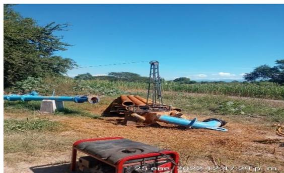
Quedando el pozo con una profundidad de 55 metros y la bomba a 50 metros dando la cantidad de agua de 33 litros por segundo, para el abastecimiento de agua potable para la ciudadanía.
