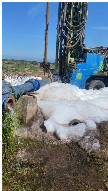
que fue un proceso de cepillado, pistoneo y desolve del pozo, se realizó el cambio de la motobomba y su caja de control de 60 HP.
